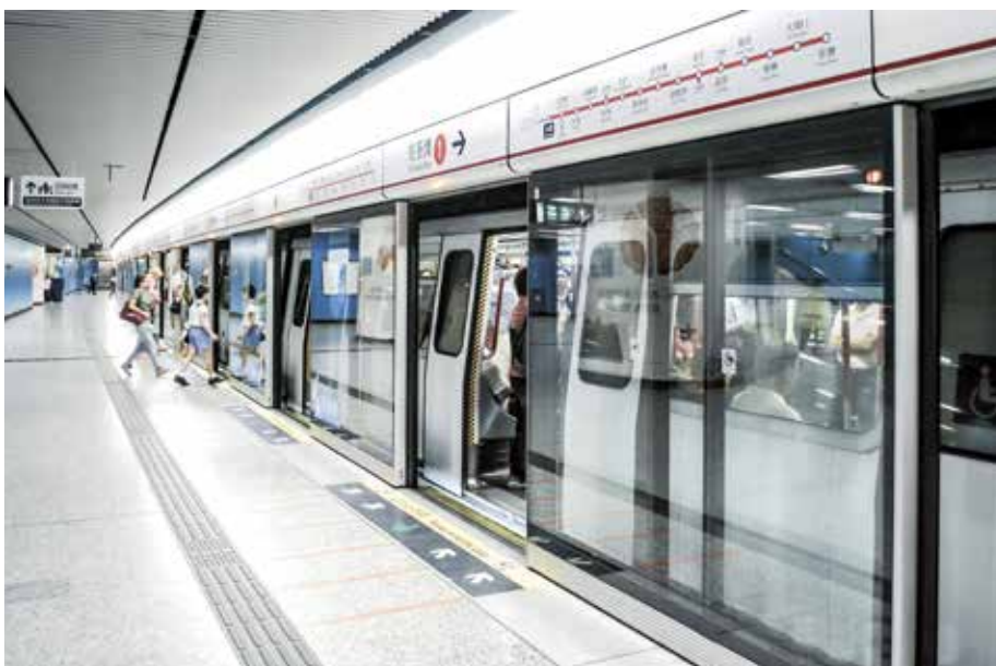
Vollautomatisierter und sicherer Bahnsteigabschluss von Gilgen Door Systems in einer U-Bahn-Station in Hongkong
